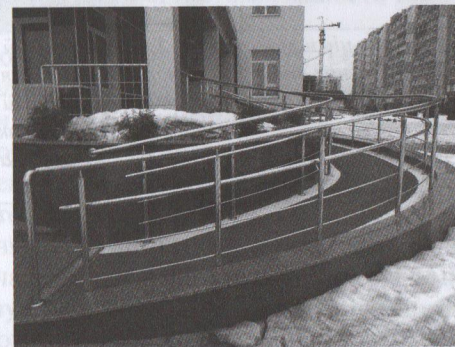
Рис. 1. Приклад архітектурної доступності закладу освіти: пандус для учнів, які пересуваються на візках
